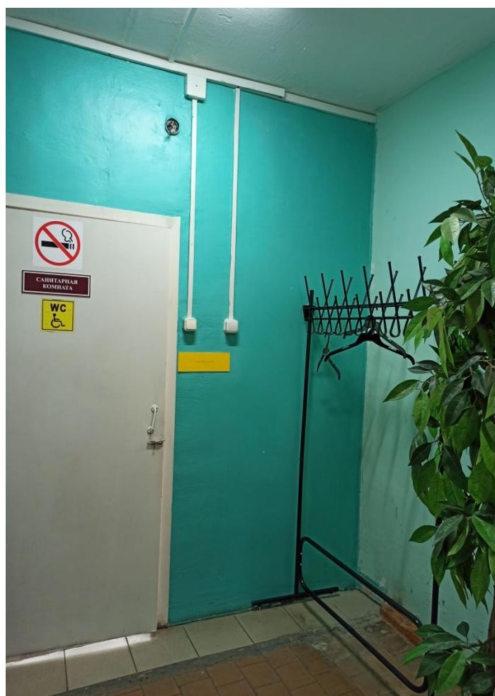
Отсутствие порогов в санитарную комнату
